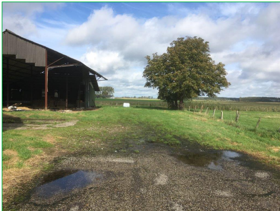
Foto 7: Asfalt op puin met daarachter puinverharding aan oostzijde grote schuur
