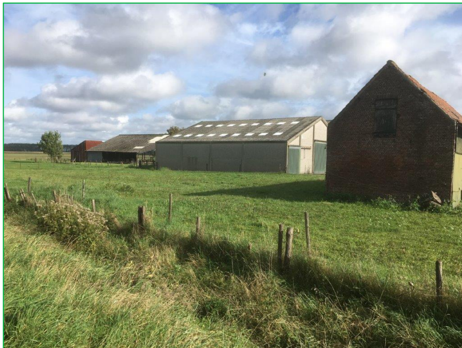
Foto 3: Onderzoekslocatie met verschillende schuren gezien in oostelijke richting
