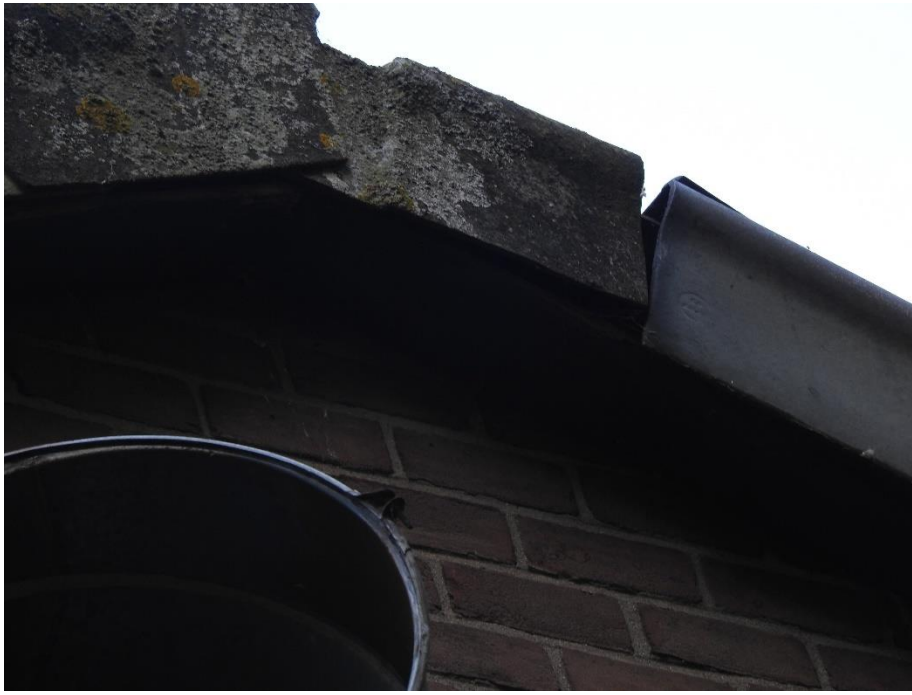
Foto 4. Opening in muur (toegang tot spouwmuur).
