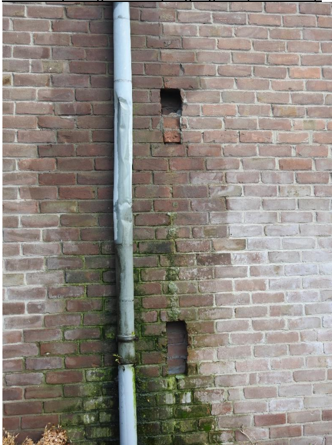
Foto 4. Opening in muur (toegang tot spouwmuur).
