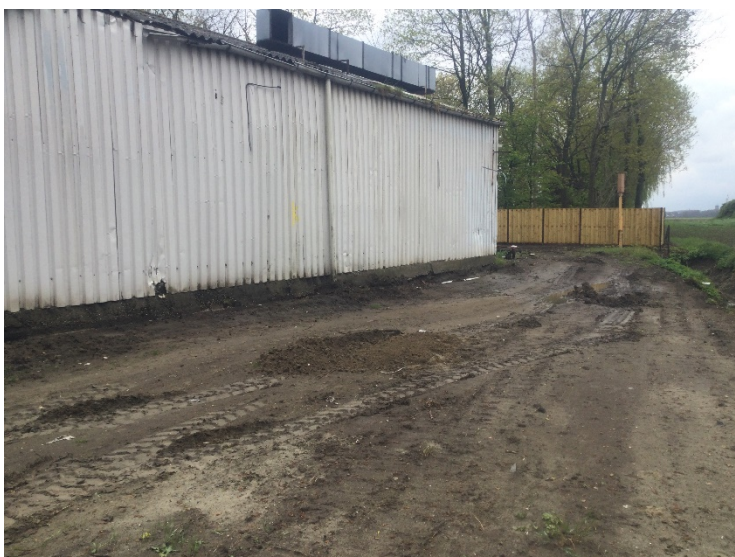
Foto 8 Sleuf 111, 112, 113 (verwijderde betonplaat)
