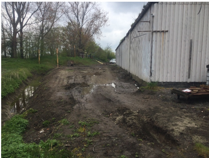
Foto 7 Sleuf 111, 112, 113 (verwijderde betonplaat)
