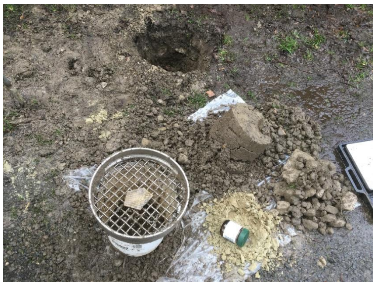
Foto 10 Inspectiegat 08, 1 stuk AVM plaatmateriaal
