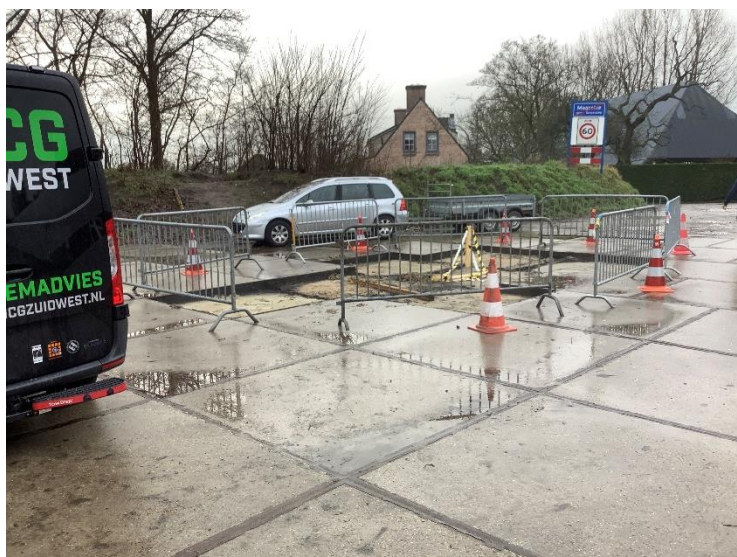
Foto 2 Zoeklocatie voormalige ondergrondse tanks
