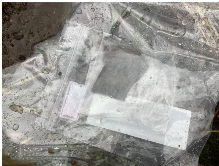
Foto 12 Stukje asbestverdacht daklei (kunstlei)
