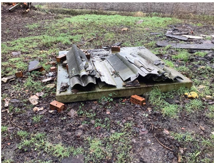
Foto 6 Kapotte dakplaten, achterzijde
