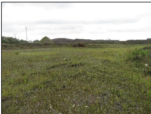
Foto 5: Plangebied vanuit het noordwesten
