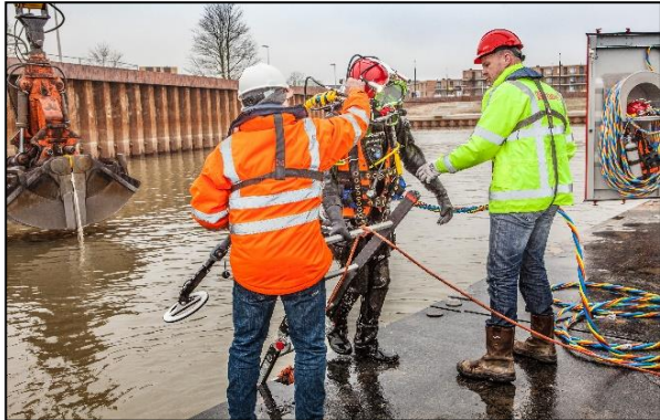
Uitvoeren actieve realtime en/of passieve realtime waterbodemdetectie d.m.v. duikploeg
