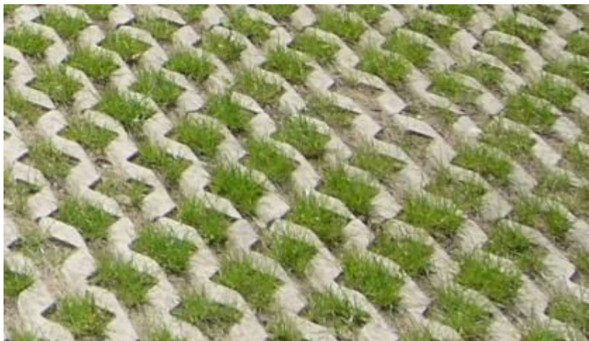
Afbeelding 7: Voorbeeld van grasbetonstenen zoals ook wordt toegepast bij de gasflessenopslag
