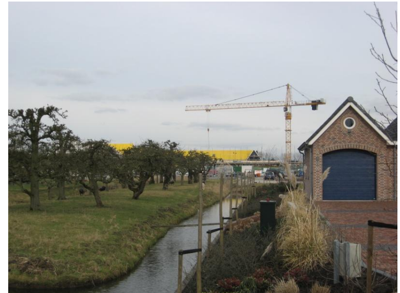
Foto 4 woonwijk de "Weide" in aanbouw aan de oostzijde
