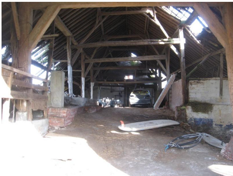
Foto 21 gebintenstructuur in de stal van de boerderij
