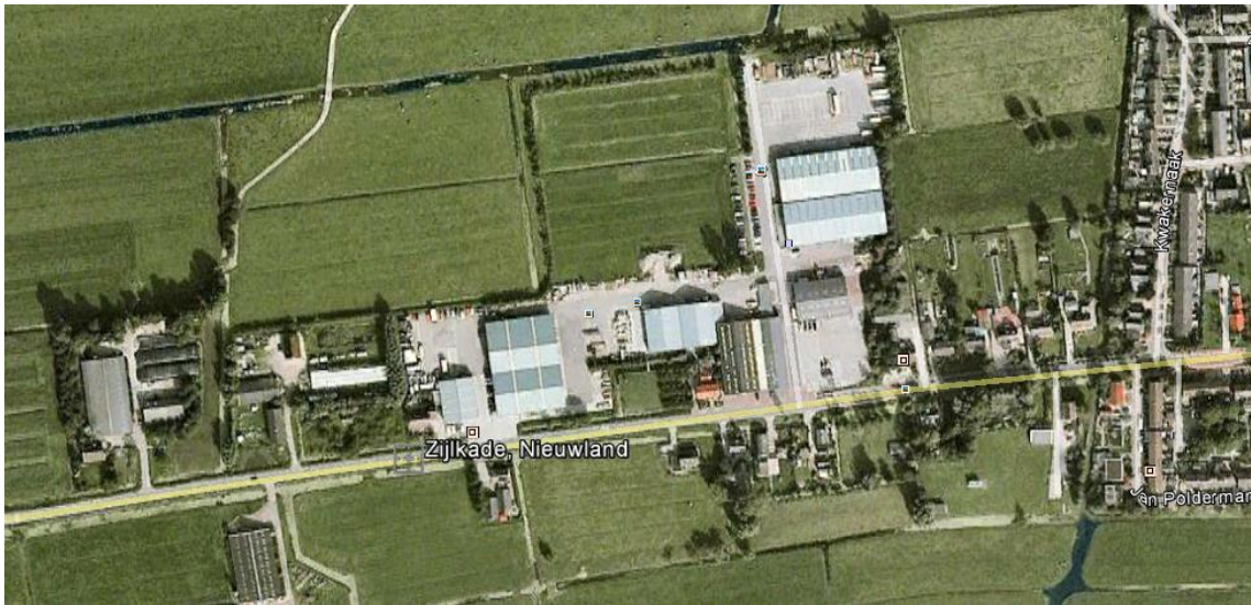
Figuur 2.1 Huidige bebouwing Zijlkade
