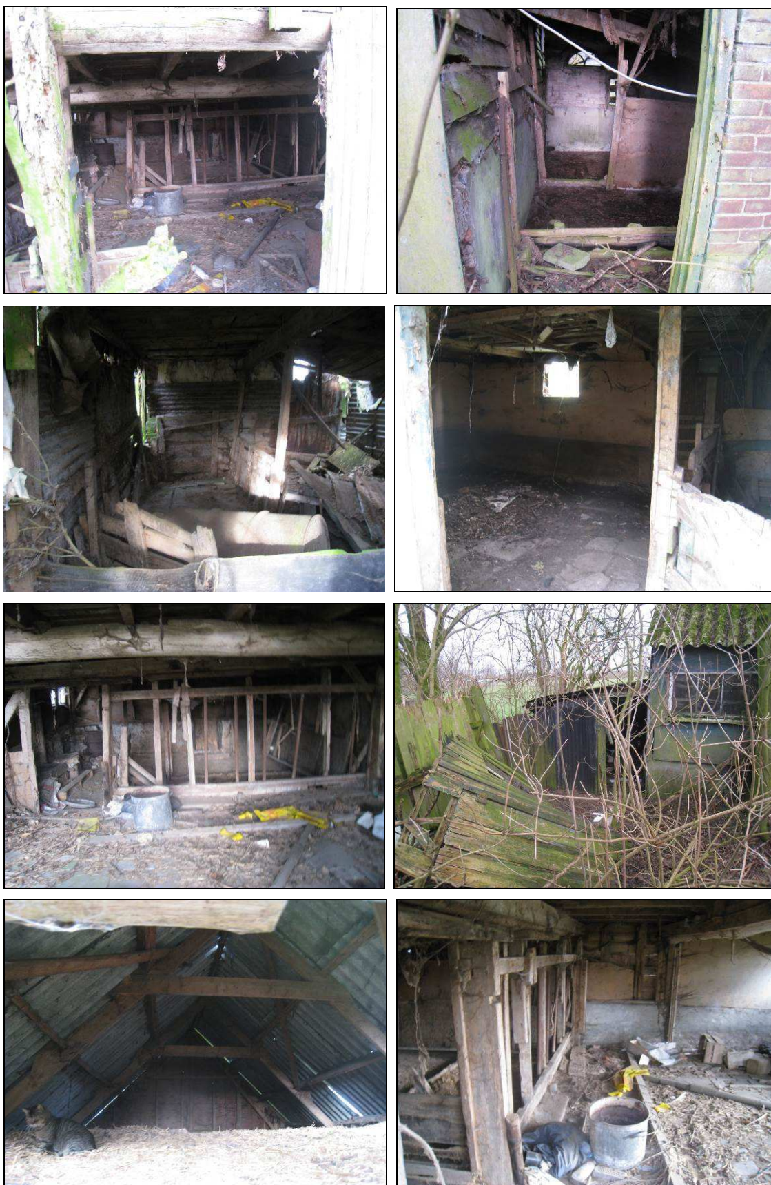
Figuur 3. Foto-impressie in pandige situatie van de te slopen opstallen Weverwijk 25-27 te Leerbroek (10-2-'15).
