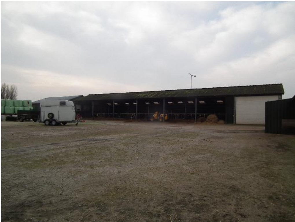
Figuur 3 De te saneren kapschuur
