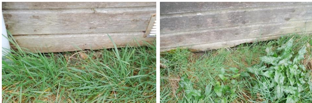
Figuur 7: Onder de vloer van de te slopen schuur zijn verblijfplaatsen mogelijk van bunzing, wezel of hermelijn. Hiernaar moet ander onderzoek worden gedaan.
