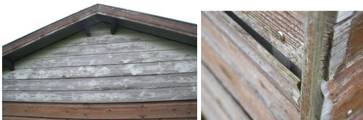
Figuur 8: Achter de houten nokgevelbetimmering is geen ruimte (zie ook figuur 6). Tussen de gevelbetimmering en de betonnen muur zijn hier en daar kieren, maar deze bevinden zich laag boven de grond (onveilig) en de ruimte erachter is te breed (tochtig) voor vleermuizen.
