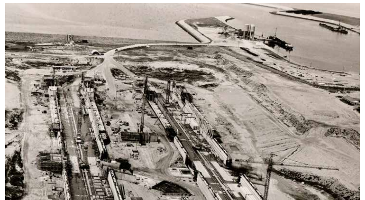
Het Kreekraksluizencomplex in aanbouw (1971)
