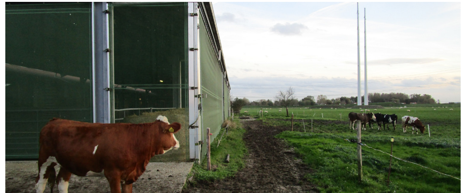
Bestaande rundveestal met open gevel waardoor er natuurlijke ventilatie mogelijk is.
