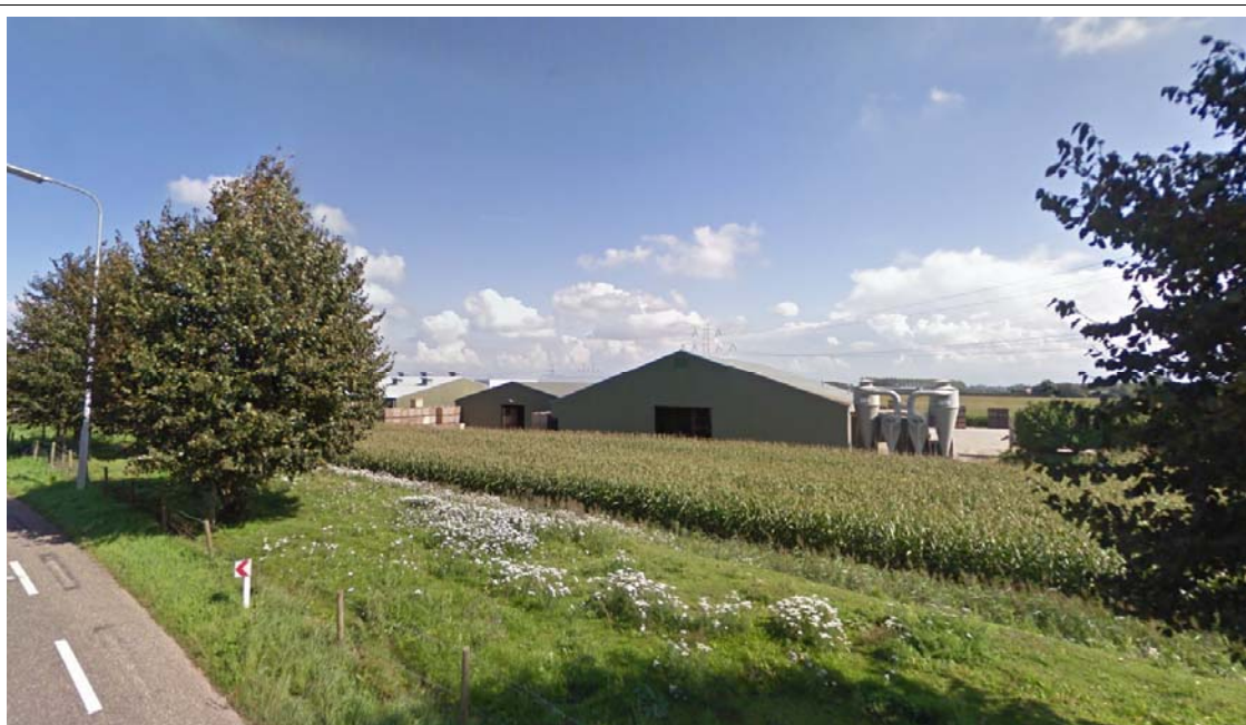
Figuur 3: Foto bestaande situatie
