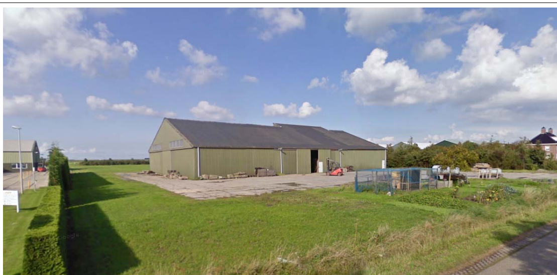
Figuur 3: Foto bestaande situatie
