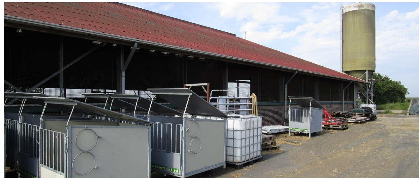
Bestaande rundveestal met open gevel waardoor er natuurlijke ventilatie mogelijk is.
