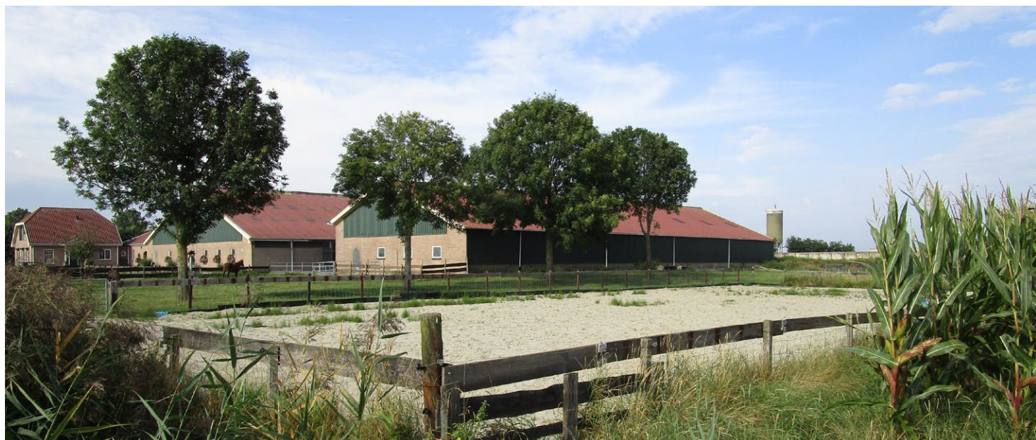
Zicht vanaf de Westhofweg op de werktuigenloods/schapenstal met de omliggende weide en bomenrij.
