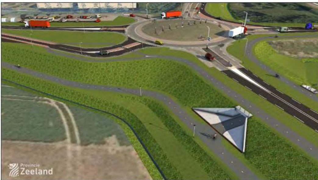
Fietstunnel Nishoek: er komen twee fietstunnels bij de rotonde Nishoek: onderdoor de Oude Rijksweg (N289) en ter hoogte van de Kamperweg. Hiermee komen de huidige, gelijkvloerse fietsoversteken te vervallen. (bron: www.zeeland.nl )
