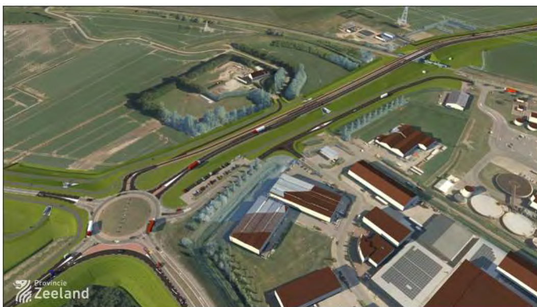
Nieuwe verbindingsweg Weihoek met Stationsweg: de Stationsweg wordt verbonden met de Weihoek en via de Weihoek met de rotonde Nishoek. De fietsroute Yerseke-Station gaat via de Capelleweg naar de Stationsweg. De Stationsweg-Weihoek krijgt een fietspad vanaf de rotonde Nishoek naar de Capelleweg. (bron: www.zeeland.nl )
