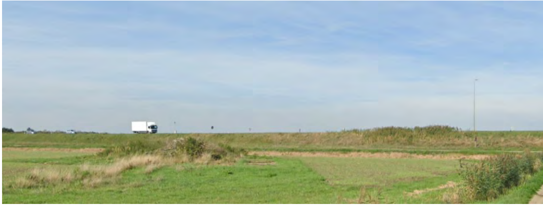
weg op dijk dominant aanwezig in open landschap zonder dijkbeplanting
