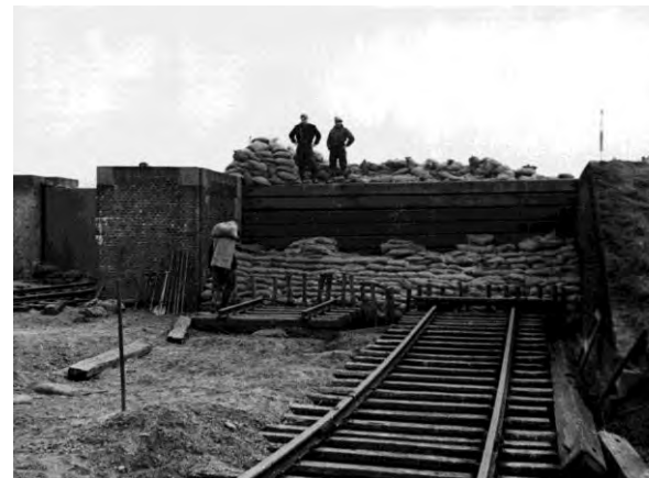
Vloedplanken versterkt met zandzakken (1953)
