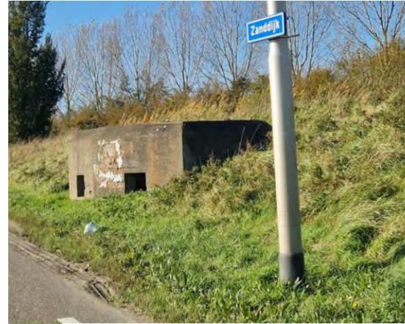
Kazematten als onderdeel van de Zanddijkstelling
