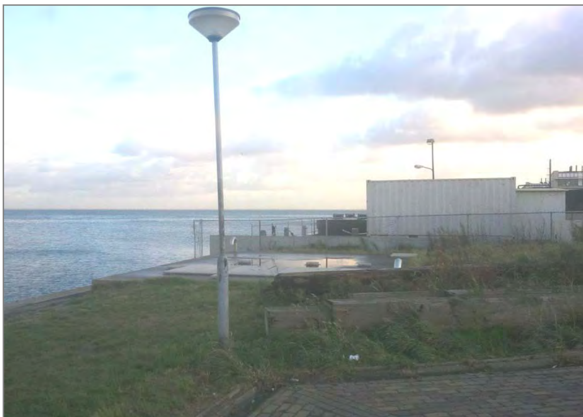
Foto 3: Gezicht op de pompput ter plaatse van kadastraal perceel Y602. De kijkrichting is zuidoostelijk
