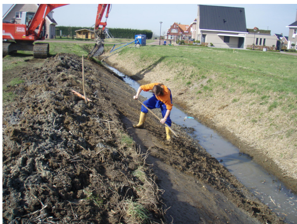
Afb. 2 (boven). Slootkantkartering. Met de kraan wordt de begroeiing verwijderd, waarna met de hand wordt geschaafd.
