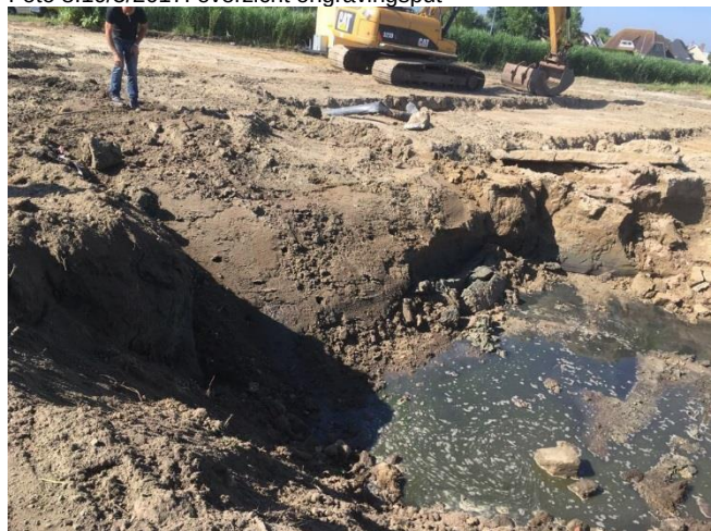
Foto 10: 14/6/2017 eindsituatie na laatste ontgraving
