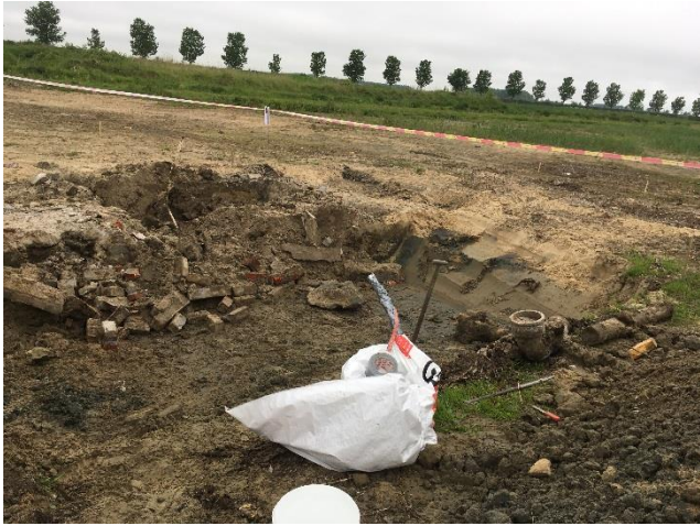
Foto 7: 18/5/2017: deel ingepakte AC pijp bij ontgravingslocatie
