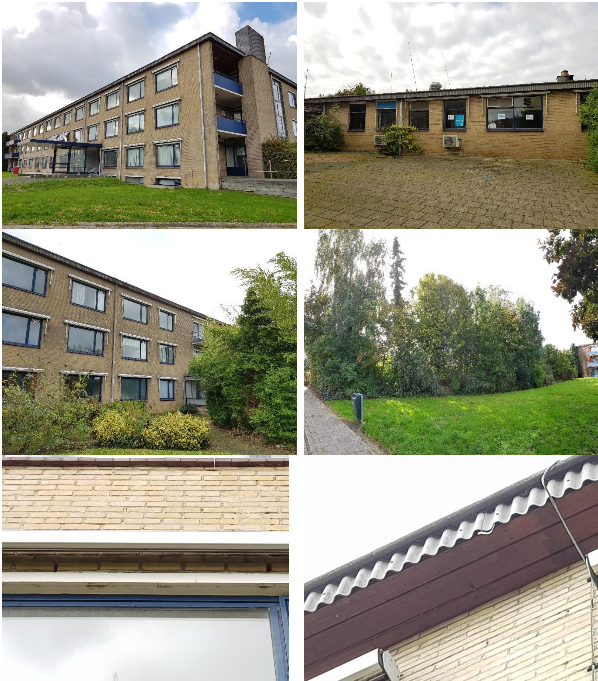
Figuur 2-1: De foto linksboven toont het gehele hoofdgebouw; rechtsboven één van de twee bijgebouwen; linksmiddelen de achterzijde van het hoofdgebouw en rechtsmiddelen de groenstrook; linksonder en rechtsonder tonen toegangen tot in de muur en achter de beplating van het gebouw.
