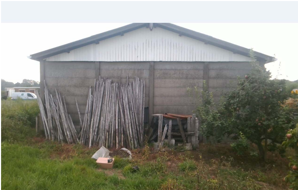
Foto 10: Locatie asbestinspectiegat G1
