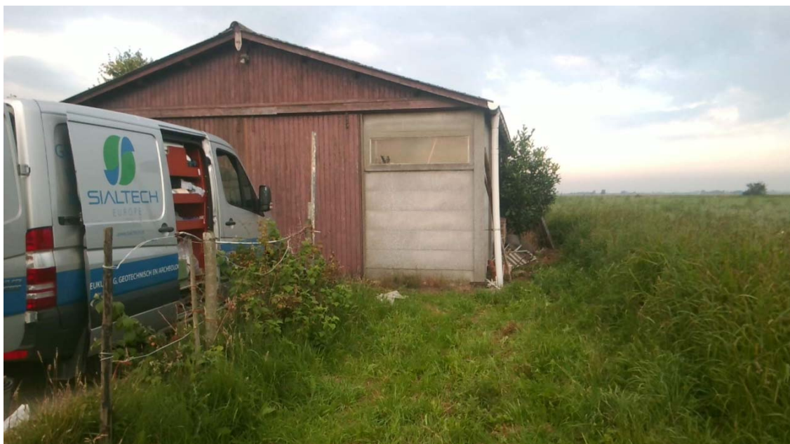
Foto 11: Locatie asbestinspectiegat G3 en G2.
