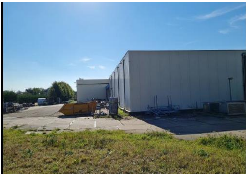
Figuur 3: Bedrijfsloods in het oosten van het plangebied
