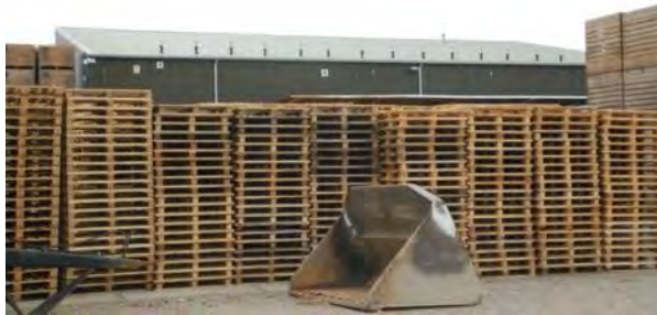
Afbeelding 6: Aansluitend op de bestaande loodsen worden nieuwe loodsen gebouwd.
