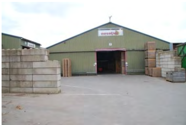
Afbeelding 7: De twee te slopen loodsen.
