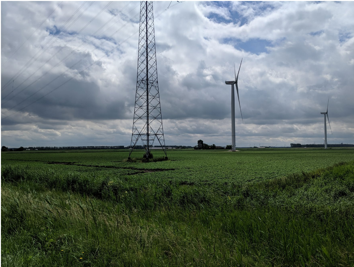
Figuur 4.7 Perceel Kreekrakpolder
