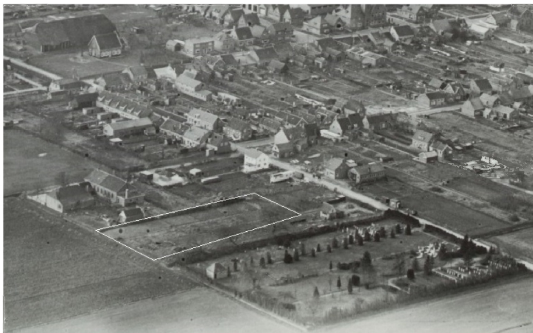
Afbeelding 19: De onderzoekslocatie (wit kader) met bouwput voor de gemeentelijke werkplaats op een ongedateerde luchtfoto (1960). De foto is genomen richting het zuidwesten. Bron: gahetna.nl, 2018; URL: http://proxy.handle.net/10648/af31aa44-d0b4-102d-bcf8-003048976d84 .
