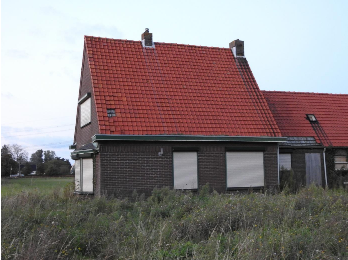
Foto 1. Te slopen bebouwing (woonhuis).
