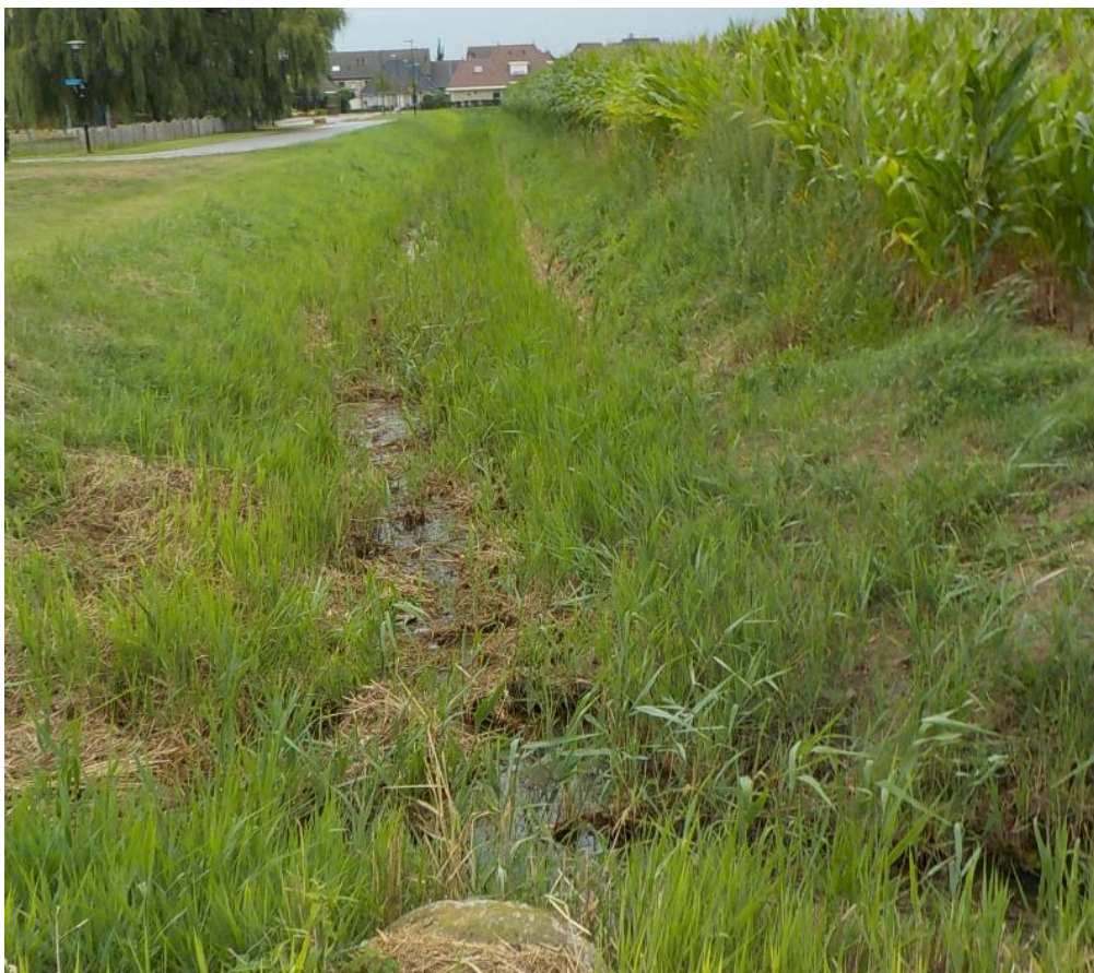
Foto 6: Sloop ter plaatse van W4.
