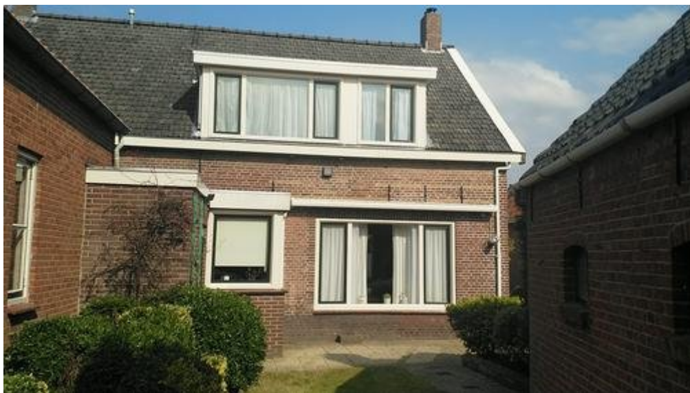
Achterzijde van het woonhuis gezien vanuit de achtertuin, het dak is geschikt als verblijfplaats van huismussen. Foto: M de Vries / Ecoresult B.V.
