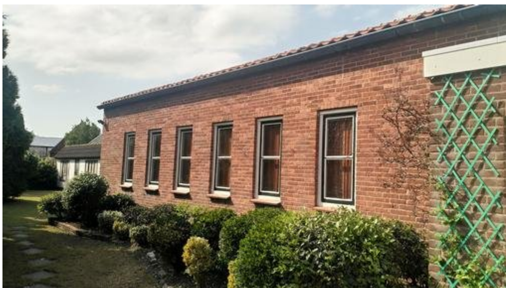
Zijgevel van het bedrijfsgebouw gezien vanuit de tuin. Foto: M. de Vries | Ecoresult B.V.
