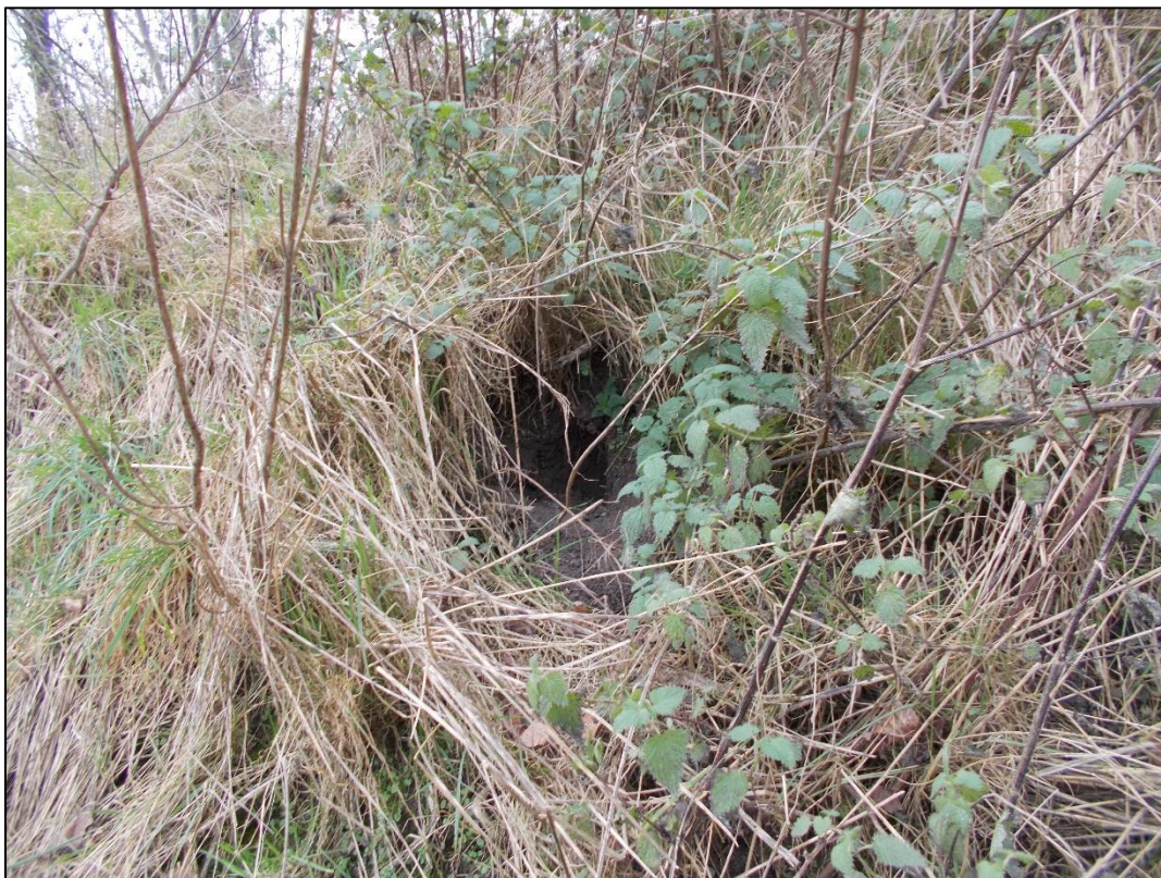
Foto 8 en 9: Aangetroffen konijnenholen in de grondwal.
