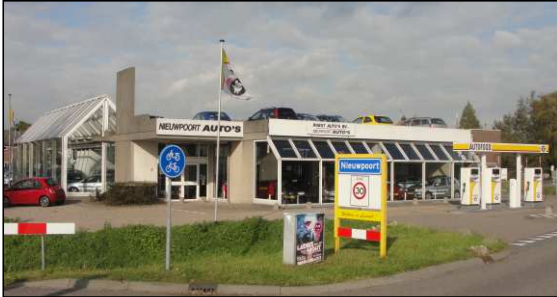
Figuur 3 Foto bestaand bedrijfspand
