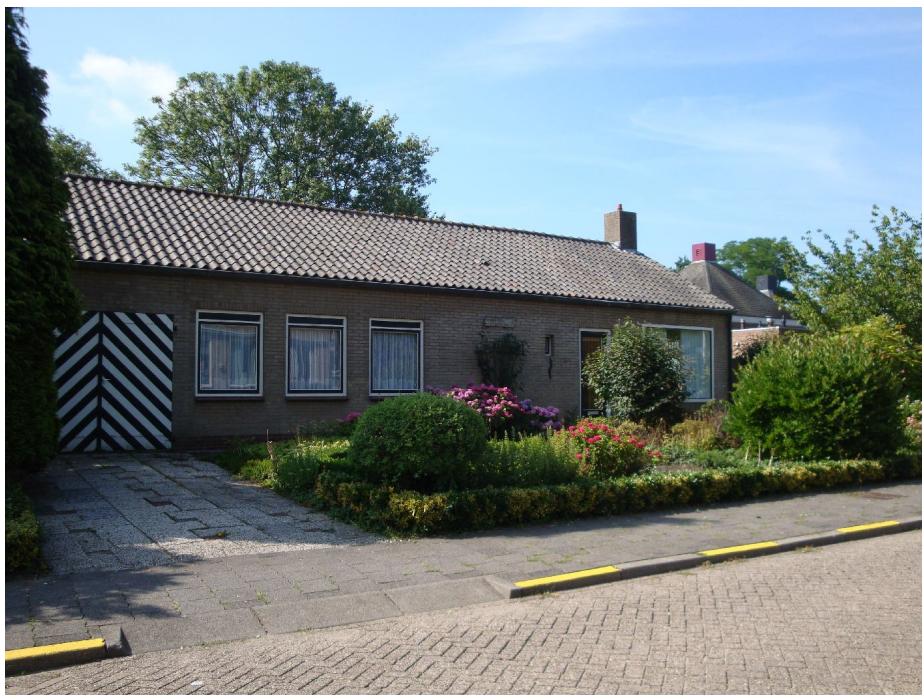
Foto; bestaande te slopen woning Schoolstraat 14
