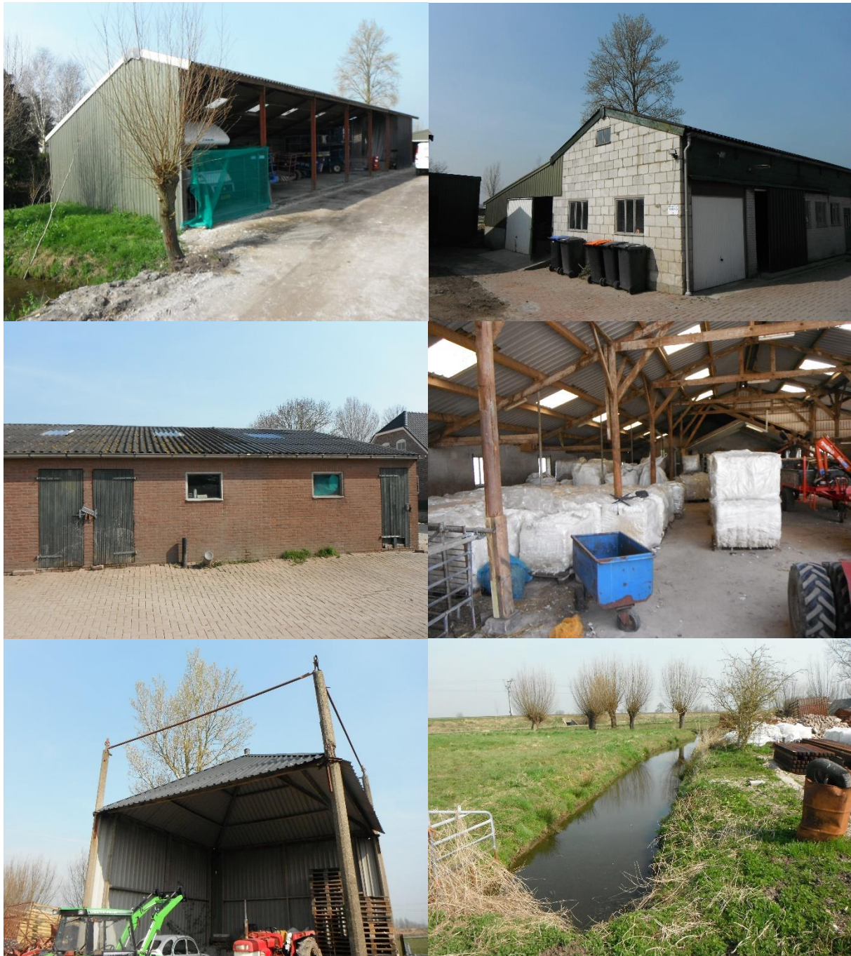
Figuur 2-3. Huidige situatie plangebied. Vanaf linksboven met de klok mee: te behouden schuur 1, te slopen schuur 2, binnenzijde schuur 4 en 6 (staan in verbinding met elkaar), watergang aan de oostzijde van het erf, te slopen schuur 5 en te slopen schuur 3.
