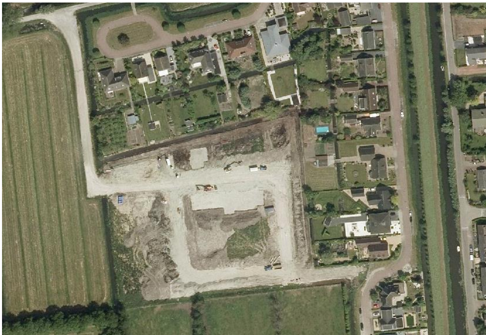
Afbeelding 2: Luchtfoto bestaande situatie
