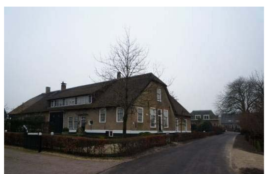
H8. Slingelandseweg e.o (de dakkapel detoneert).
