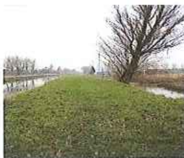
Figuur 3.3: Dijk langs A-watergang
