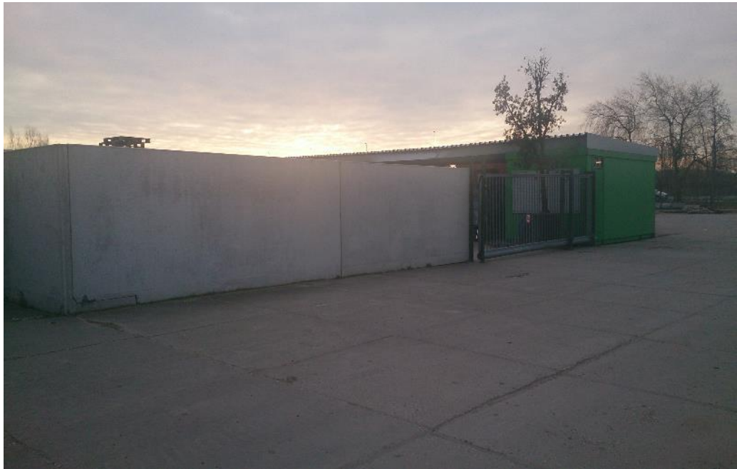
Figuur 3 Op de planlocatie is ook een tijdelijke opslagruimte aanwezig. De opslagruimte betreft met name metalen en betonnen materialen.
