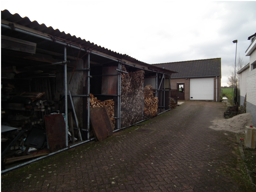
Figuur 4 De overkapping wordt thans gebruikt en zal worden gesloopt ten behoeve van een nieuwbouwwoning. De schuur achter op het terrein blijft behouden.
