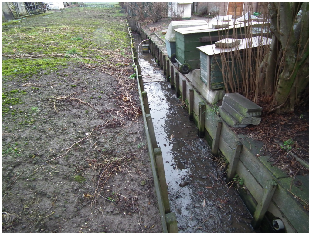
Figuur 2 De locatie wordt aan de noord- en oostzijde begrensd door een nagenoeg drooggevalle sloop. De sloop is tevens beschoeid.
