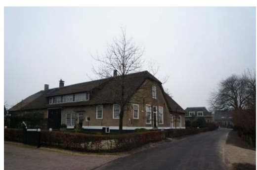
H8. Slingelandseweg e.o (de dakkapel detoneert).
