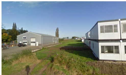
Zicht op uitbreidingslocatie
