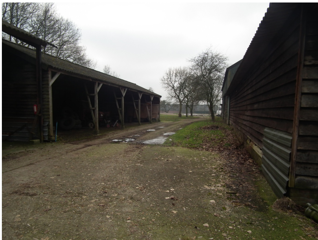
Figuur 2 Op het terrein zijn een tweetal te slopen schuren aanwezig. Een derde schuur blijft behouden als bijgebouw van de woning.
