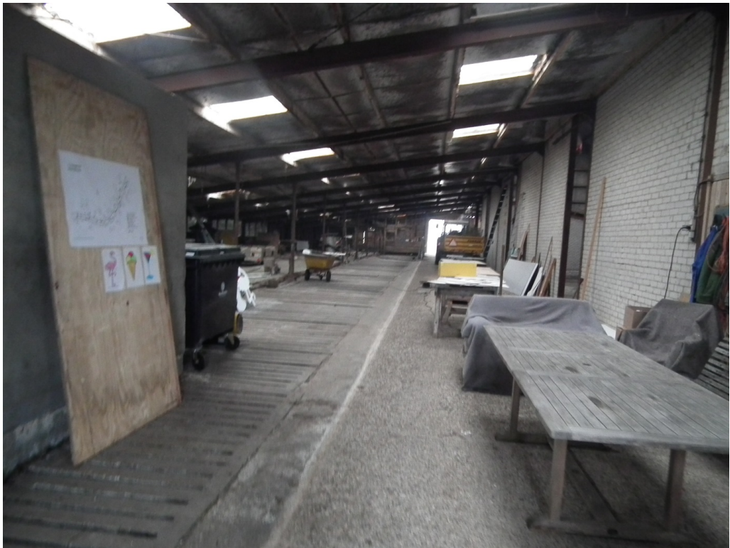
Figuur 3 De voormalige agrarische schuren zijn doorgaans in gebruik als hobbyruimte en dienen tevens als opslag.
