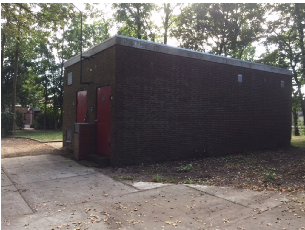
Figuur 2 Het bijgebouw heeft gemetselde muren en een plat dak (bitumen). Het omliggende terrein is verhard of bestaat uit gazon.
