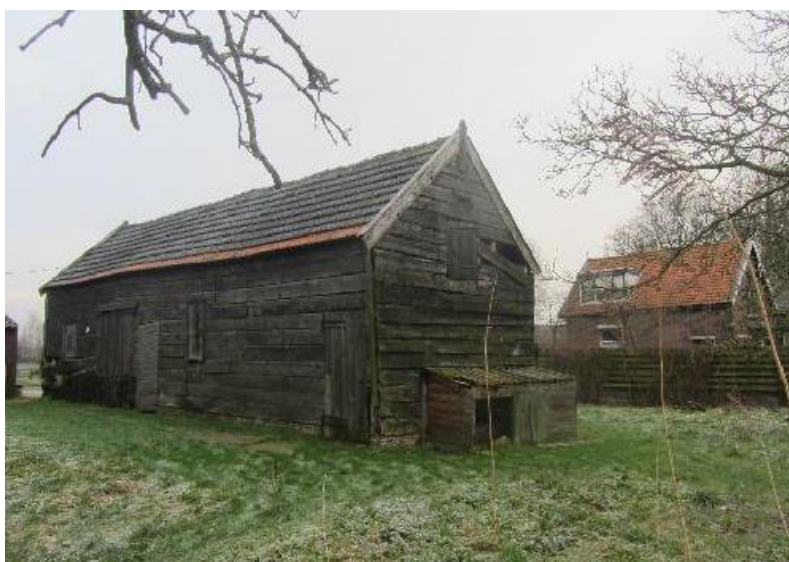
Afbeelding 3: Bestaande situatie vervallen schuur naast boerderij
