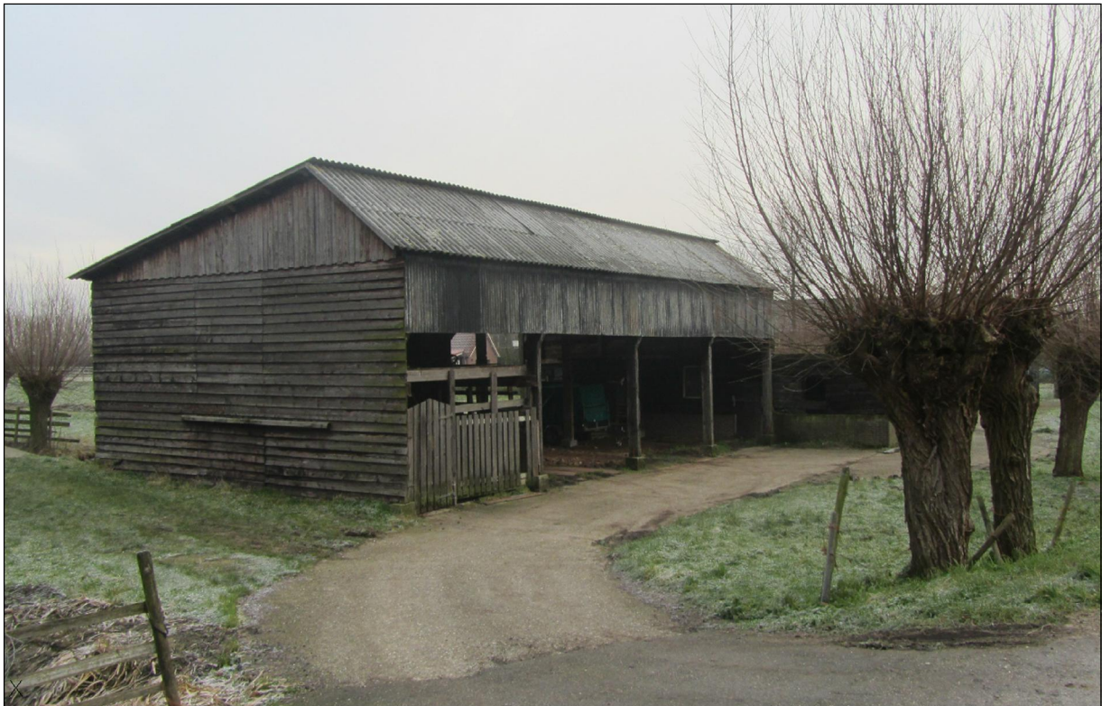
foto bestaande situatie schuur overzijde
