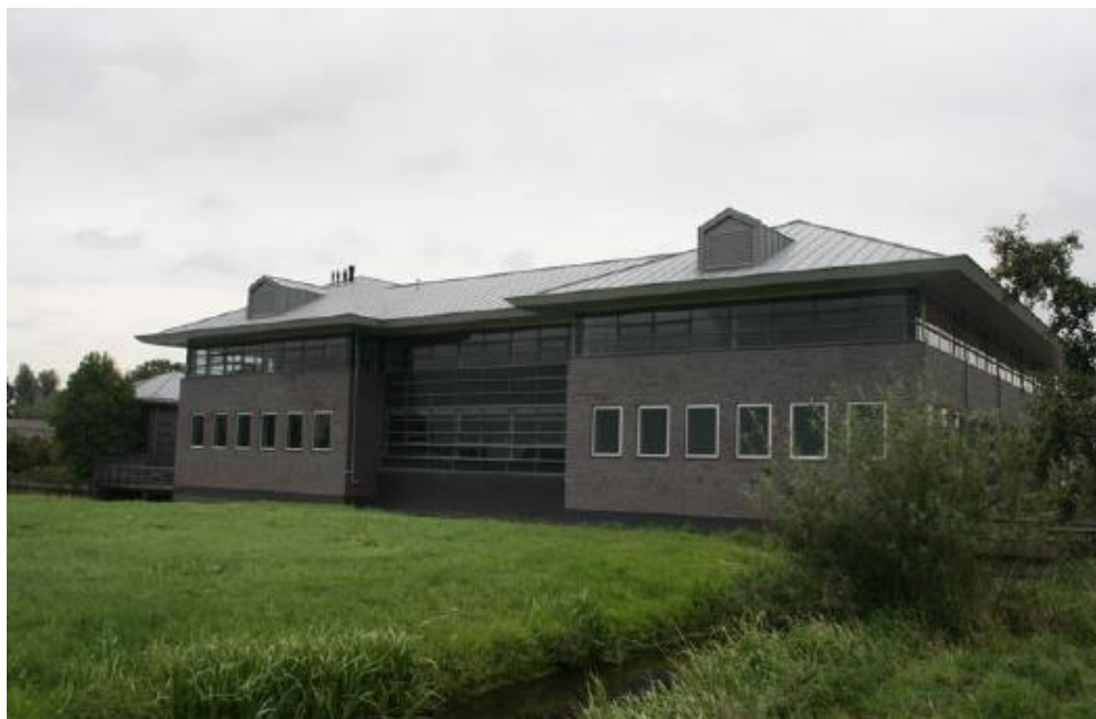
Afbeelding 2: foto noordgevel bestaande gebouw
