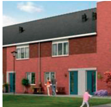
spel met twee kleuren metselwerk, horizontale koppelingen
