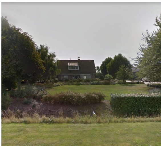
Foto 1: Vooraanzicht woonhuis, vanuit het noorden.
